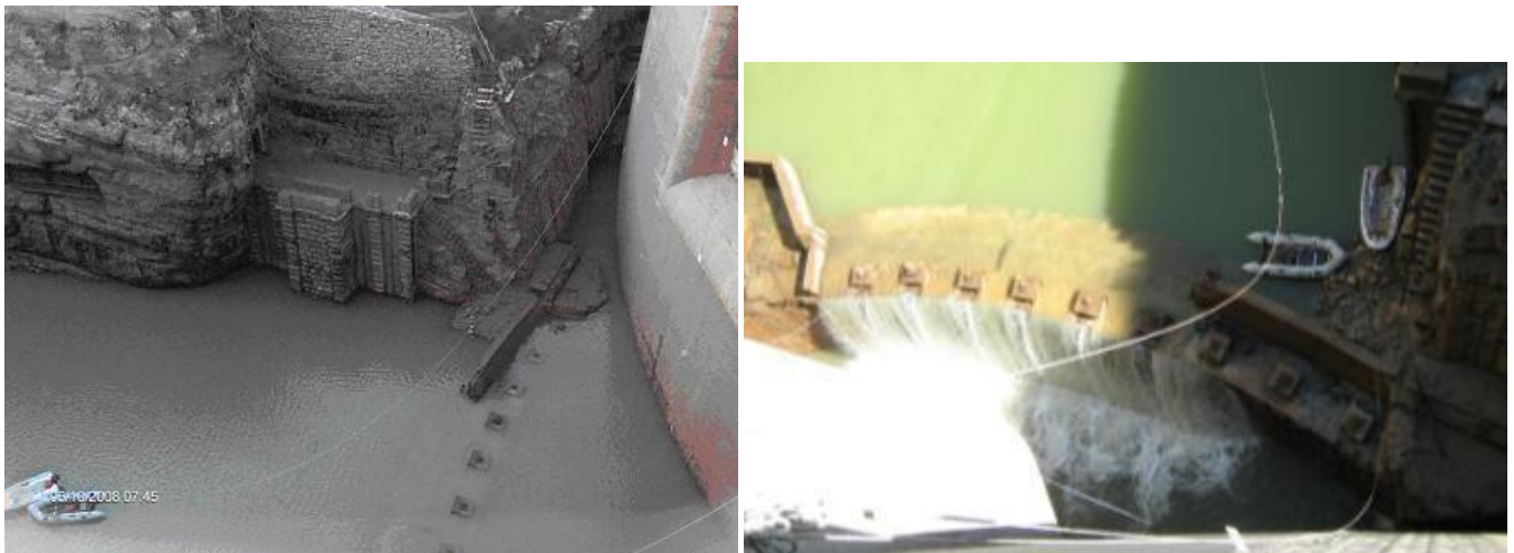
Figure 8 : Batardeau amont lors de la vidange de la retenue de Quinson en 2008
