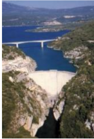
Figure 9 : Barrage de Sainte-Croix - vue de l'aval
