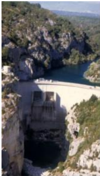
Vanne vidange de fond et évacuateurs de crue
